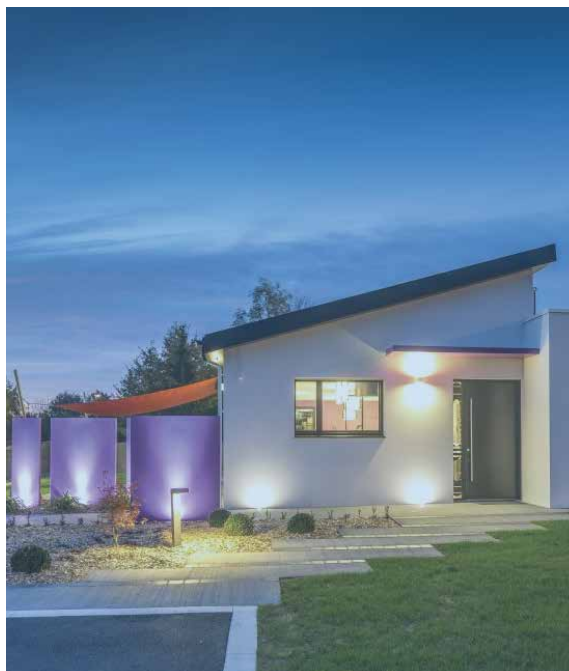
Bepos Effinergie 2013 | La Ferrière (85) | Constructeur : La Bocaine
